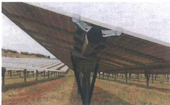
Hekwerk, trackersysteem en achterzijde panelen (Bron: landschappelijk inpassingsplan).
